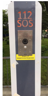
街角の所々に押しボタン式の緊急通報装置が設置されています。
